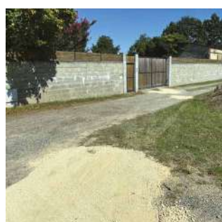
8 Travaux d'empierrement (ici Route Pomiro)
