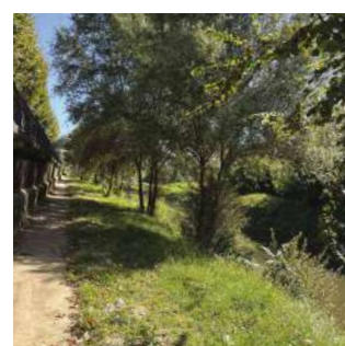
10 Désensablage des berges des allées marines
