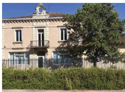
1 Changement de la clôture de l'école
