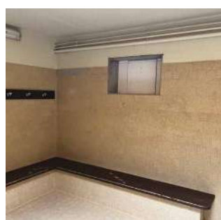
12 Travaux des vestiaires du gymnase
